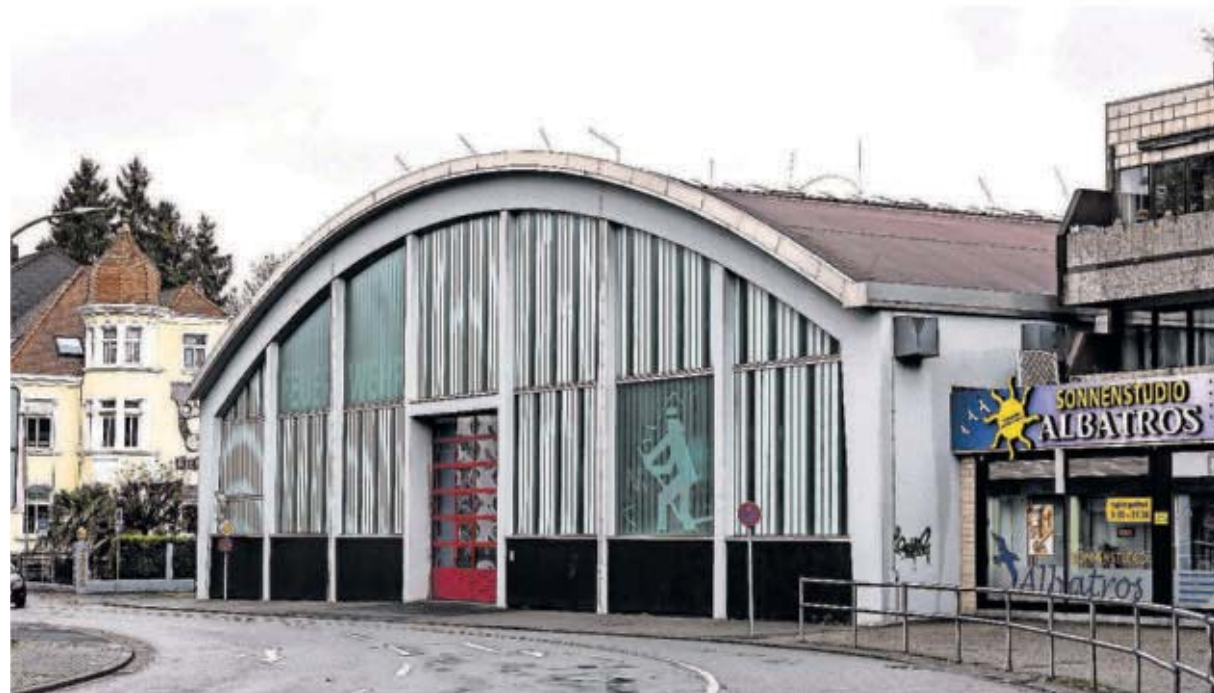
Die Feuerwache des Löschbezirks Saarlouis Innenstadt. Weil sich ein tragendes Bauteil verformt hat, ist die Halle bis auf Weiteres gesperrt. Jetzt muss untersucht werden, wann die Feuerwehr zurück in die Halle kann. FOTO: ROLF RUPPENTHAL
