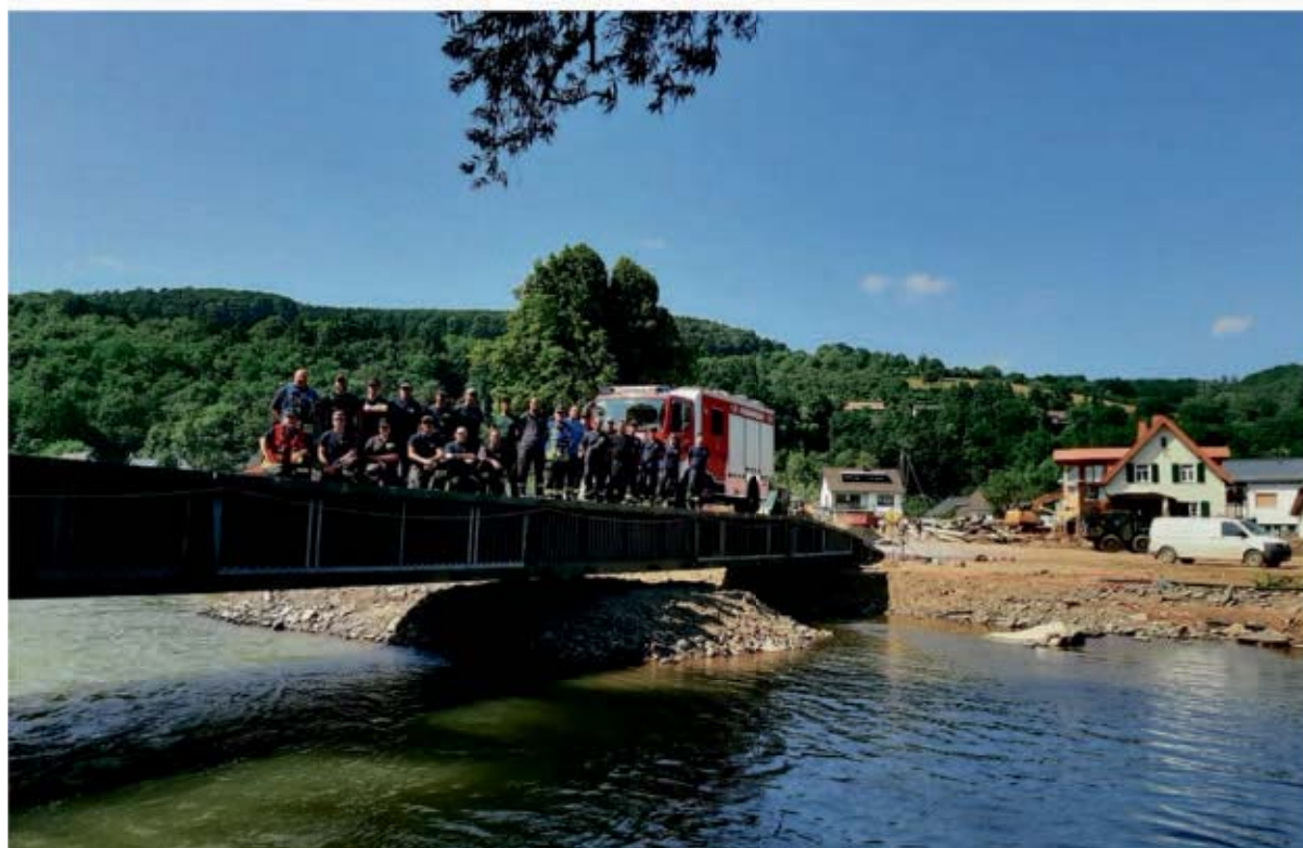
Nachdem die Brücke in Insul durch das katastrophale Hochwasser im Juli vollständig zerstört worden ist, halfen Mitglieder der Freiwilligen Feuerwehren aus Schwalbach, Saarwellingen und Nalbach beim Bau einer provisorischen Überquerung über die Ahr.
