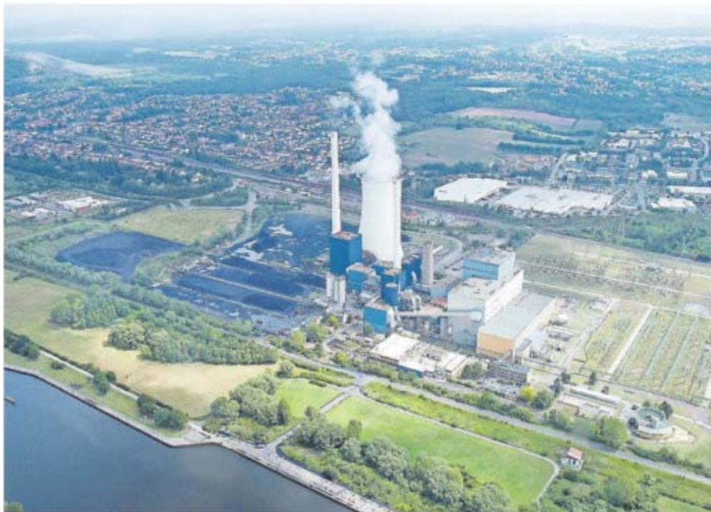
Das VSE-Kraftwerk Ensdorf AR-CHIVFOTO: IRIS MAURER
