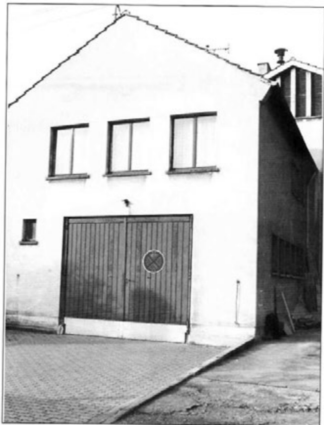
Feuerwehrr- gerätehaus im Schlachthaus- weg (1956 - 1981)
