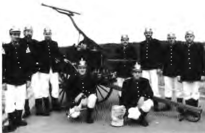
Handpumpe des Herstellers Carl Metz Baujahr: um 1875 Antrieb: 8 bis 10 Mann Leistung: 200 l/min bei 55 Doppelhüben
