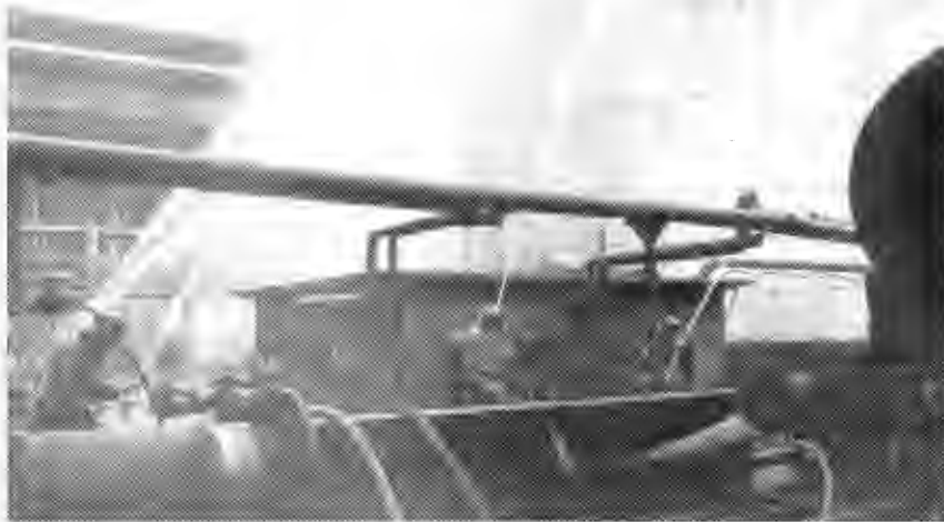
Bild 15 Hauptübung am 26.9.1956 in der Benzolfabrik.
