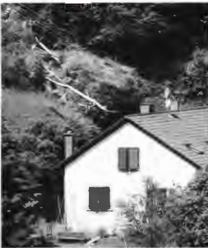
Ein mächtiger Felsbrocken droht auf ein Haus in Bervus zu stürzen.
