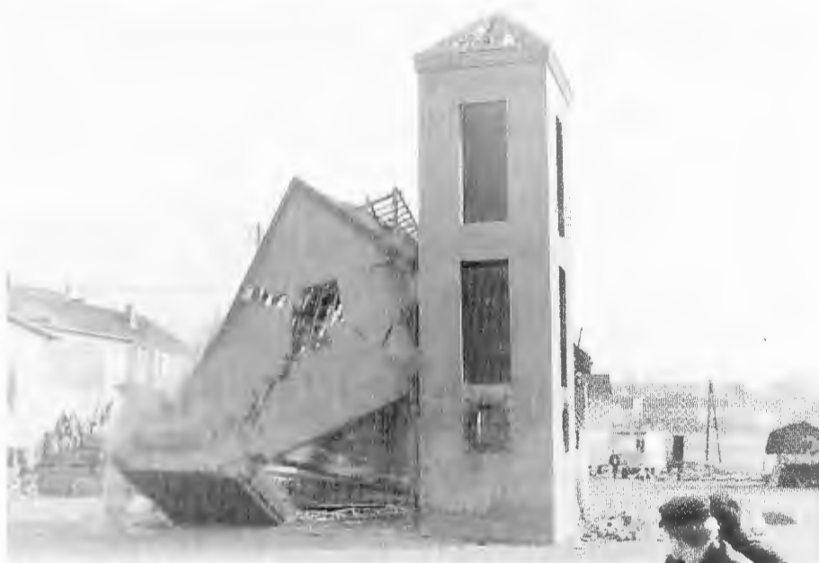
Abriss des Gerätehauses am Schulplatz 1967
