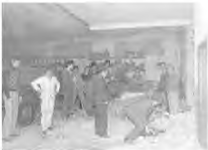
Gerätehaus Grubenstraße Umbau 1982/83
