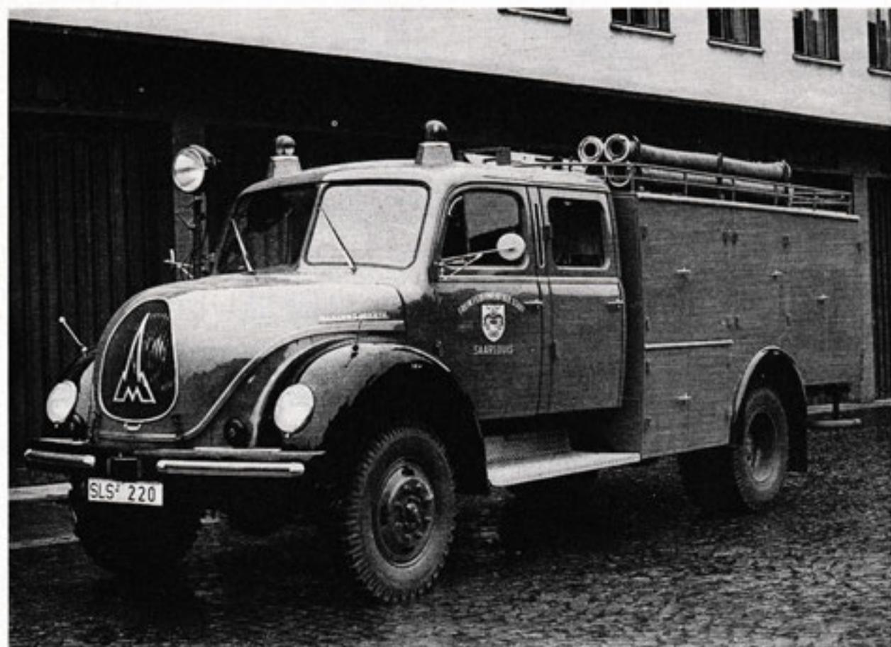
Magirus-Tanklöschfahrzeug mit Trockenpulveranlage „Trowa“
