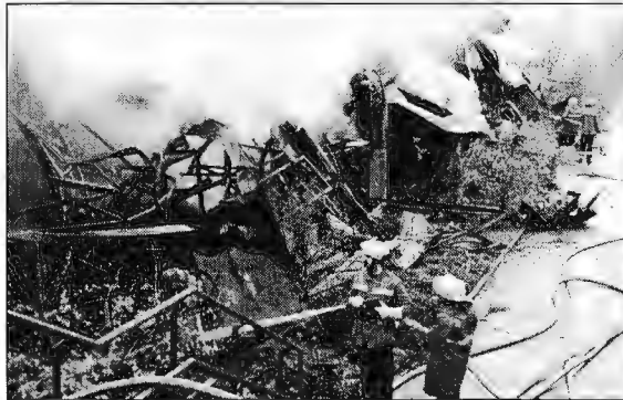
SPÄTER: Die verglühenden Reste der durch einen Brand total zerstörten Halle werden von den Wehrmännern abgelöscht. Das Verwaltungsgebäude blieb unzerstört.
