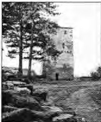
Nach mehr als 100 Jahren: Der restaurierte Turm 1998.
