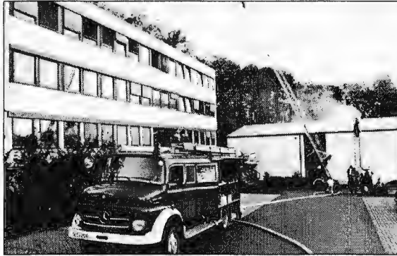
VORHER: Das Verwaltungsgebäude und das Lager der MOI AG in Siersburg waren eines von vielen Übungsobjekten.
