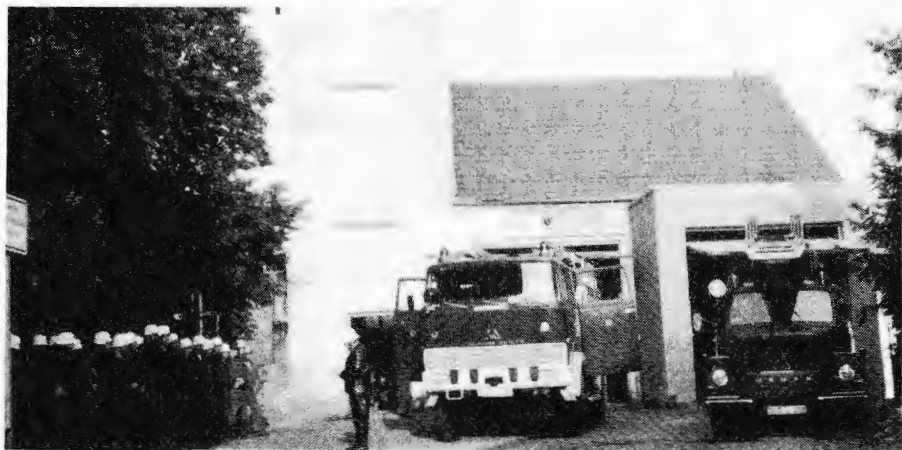
Altes Feuerwehrgerätehaus nach dem Anbau
