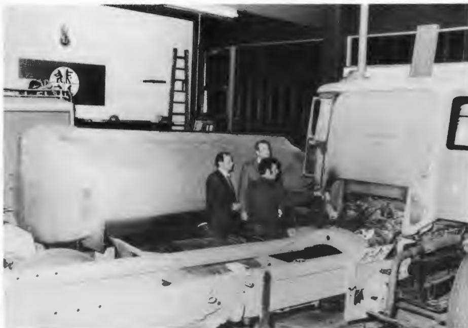
Im Jahr 1984 wird von der Firma Altmeyer ein gebrauchtes Tankfahrzeug gekauft und von einigen Feuerwehrmännern zu einem Großraumtanker mit ca. 12.000 ltr. Wasser Inhaltsvermögen umgebaut. Da das Führerhaus und einige andere Teile zum Teil erneuert werden mußten, konnte das Fahrzeug erst im Mai 1985 fertiggestellt werden.
